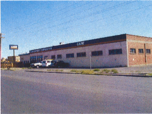
U. T. El Paso Asset ID #250023 410 S. Cotton El Paso, El Paso Co., Texas Date of Construction: 1948
