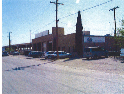
U. T. El Paso Asset ID #250051 1708 E. Paisano El Paso, El Paso Co., Texas Date of Construction: 1949
